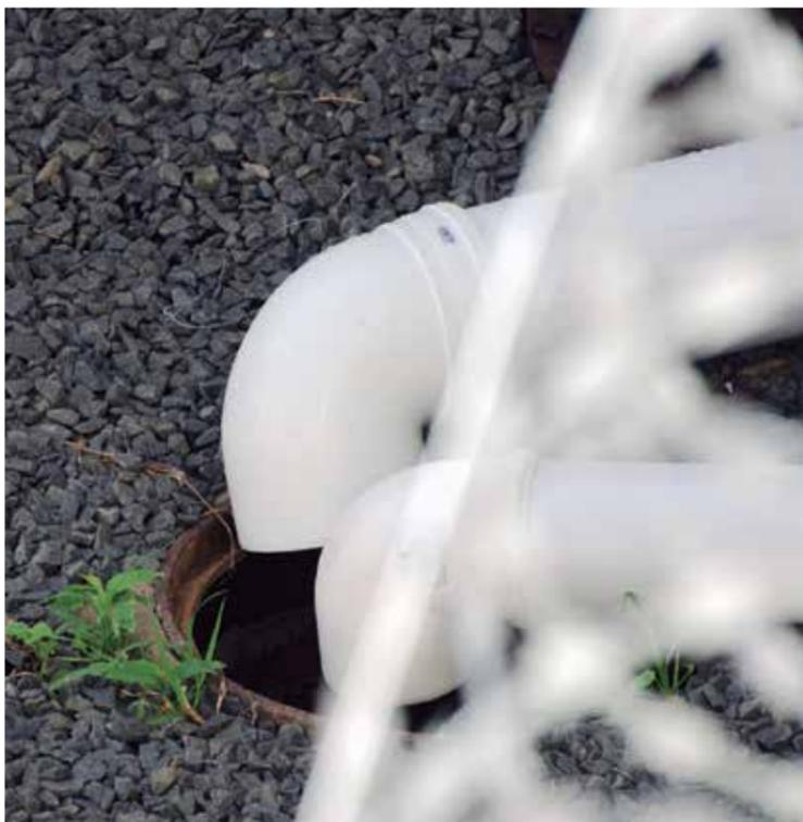
Canos de pvc despejam água pluvial na rede de esgoto no terreno onde está a torre da Claro
