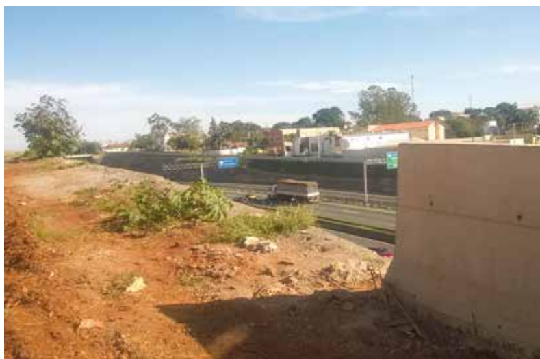
Risco 1: paredão sem proteção para pedestres e motoristas
