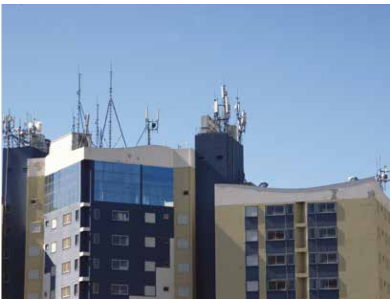
Hotel Estudiantil, no Santa Cândida, tem várias antenas instaladas na sua cobertura
