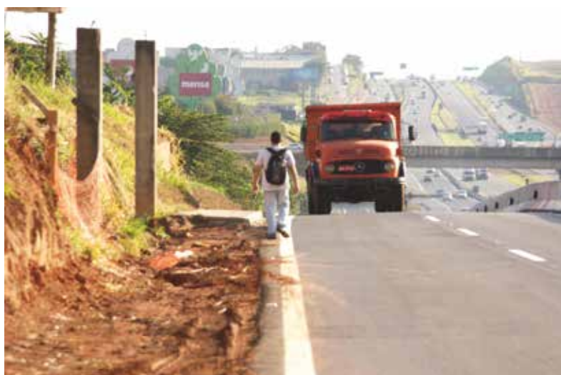
Risco 2: pedestre é obrigado a andar pelo asfalto por falta de calçada no trecho
