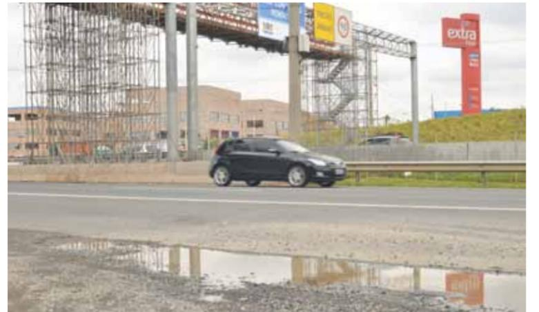
Estrutura metálica que serve de passarela deve ser substituída por uma de concreto
