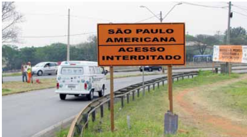
Sinalização intensa para ajudar os motoristas a seguirem pelo novo desvio
