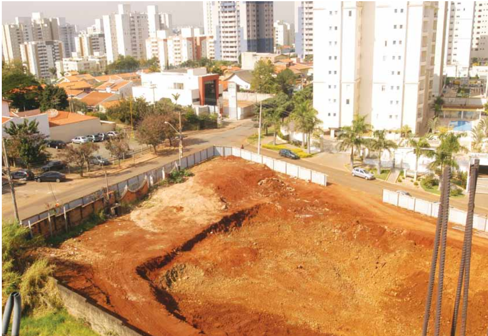
Obra realizada no local onde será erguido o novo supermercado enfrenta dificuldades em função do maciço de pedra existente no solo da região
