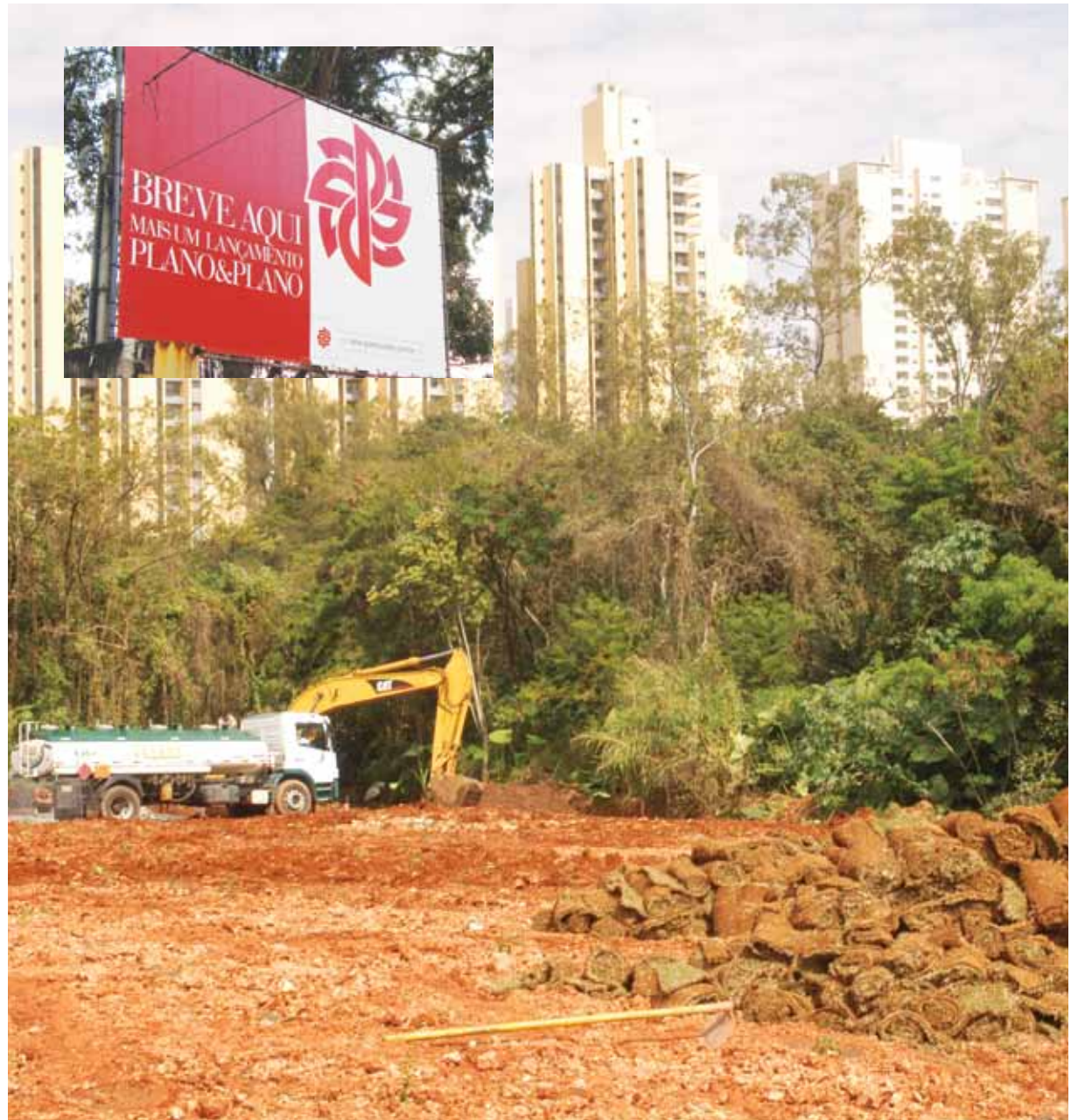
O novo empreendimento vai ocupar área junto ao córrego e, em função de assoreamento, foi necessário o remodelamento local
